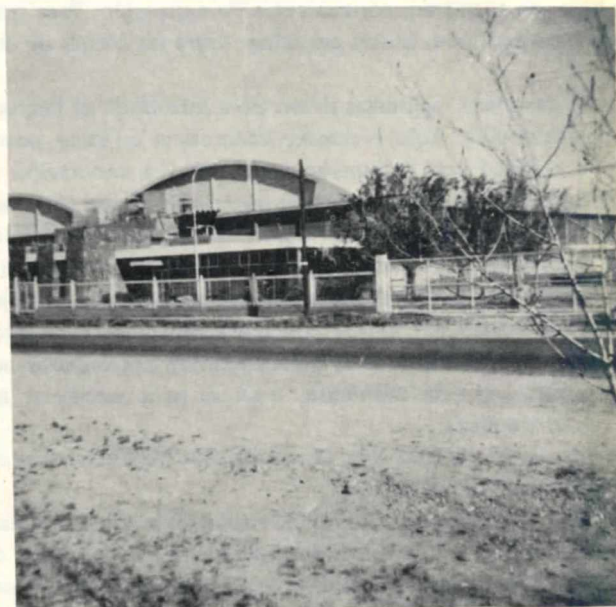
Fot. 1 — Moderna empresa instalada sobre la ruta 4.
