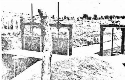
Fot. 28 — Derivadores del Canal Norte en el valle de San Pablo (Foto J. Ostuni).
