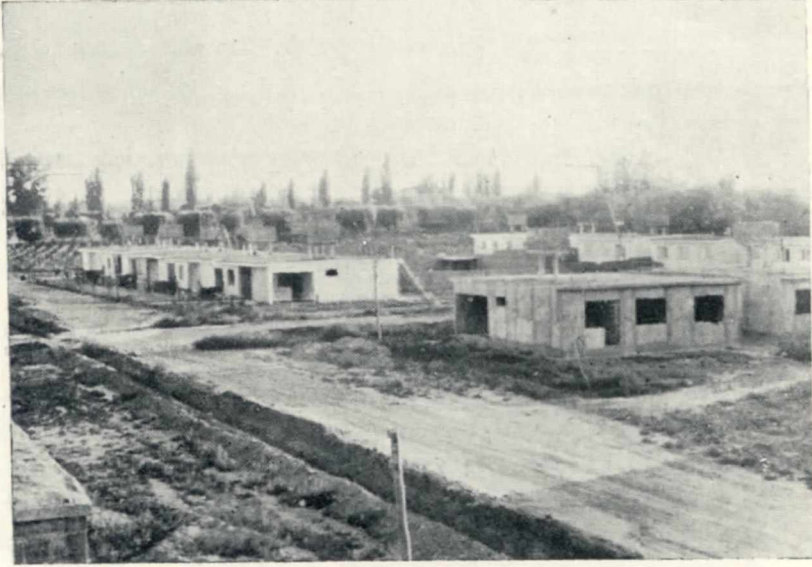
Fot. 5 — Barrio La Colina. Casas en construcción y otras ya ocupadas por obreros de la empresa.
