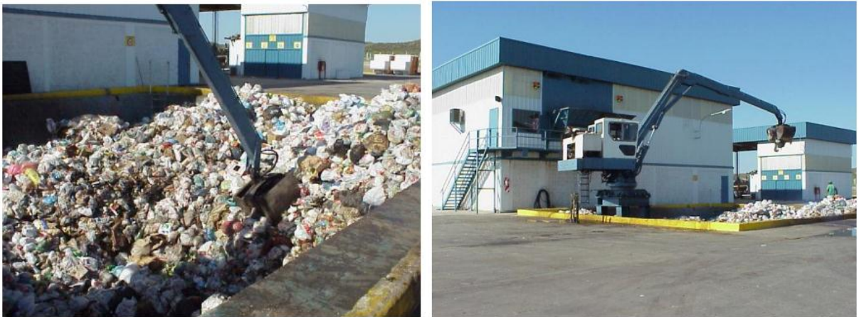
Ilustración 30 Instalaciones Maipú: Pozo y Brazo hidráulico
