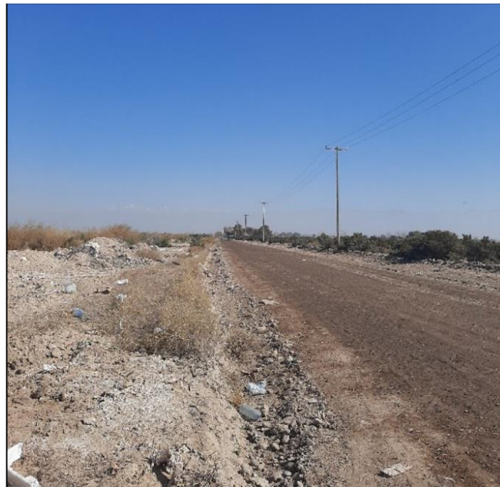
Fotografía 9: Vista del ingreso a la escombrera sobre calle Roque S. Peña
