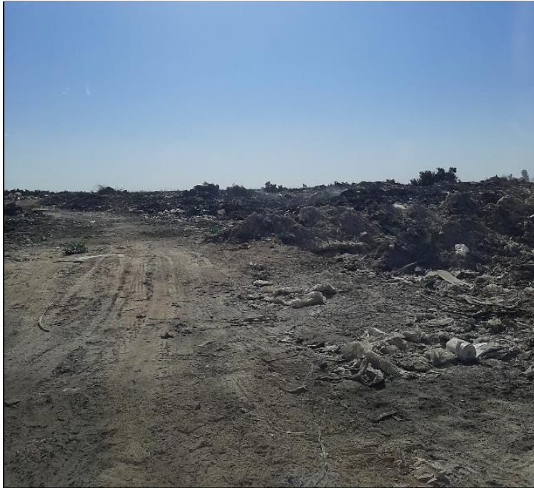
Fotografía 4: Vista de los caminos internos de la escombrera proyectada
