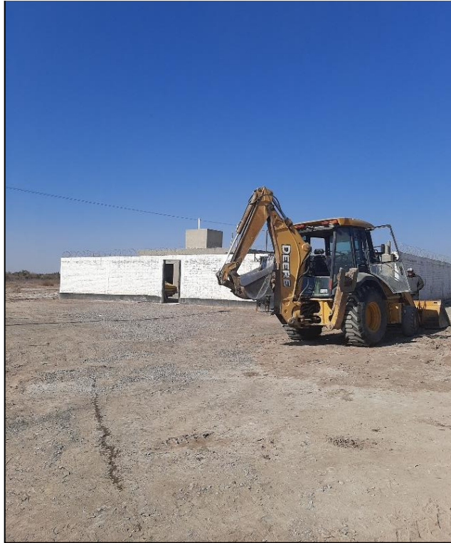
Fotografía 1: Vista del ingreso a la nueva escombrera proyectada
