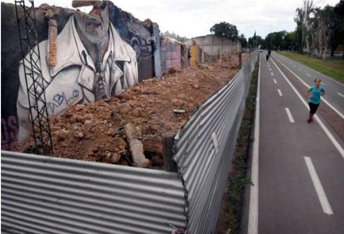
Imagen 35: Demolición y pérdida de los murales.
