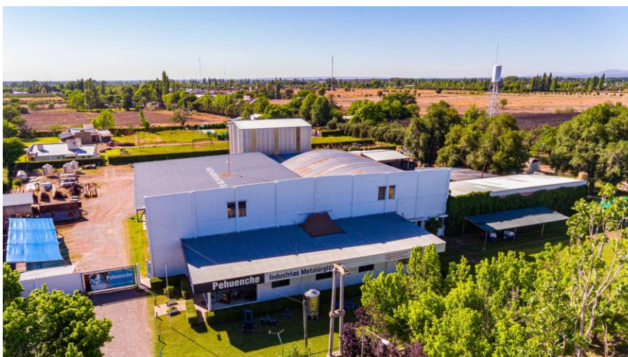
Imagen N° 1: Instalaciones de la empresa Pehuenche.
