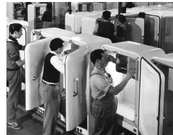
Línea de montaje de Heladeras Industrias SIAM
