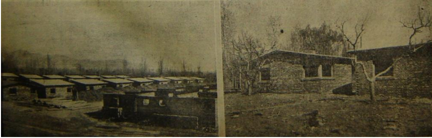
Figura 6: Viviendas del barrio 4 de Junio en construcción.
